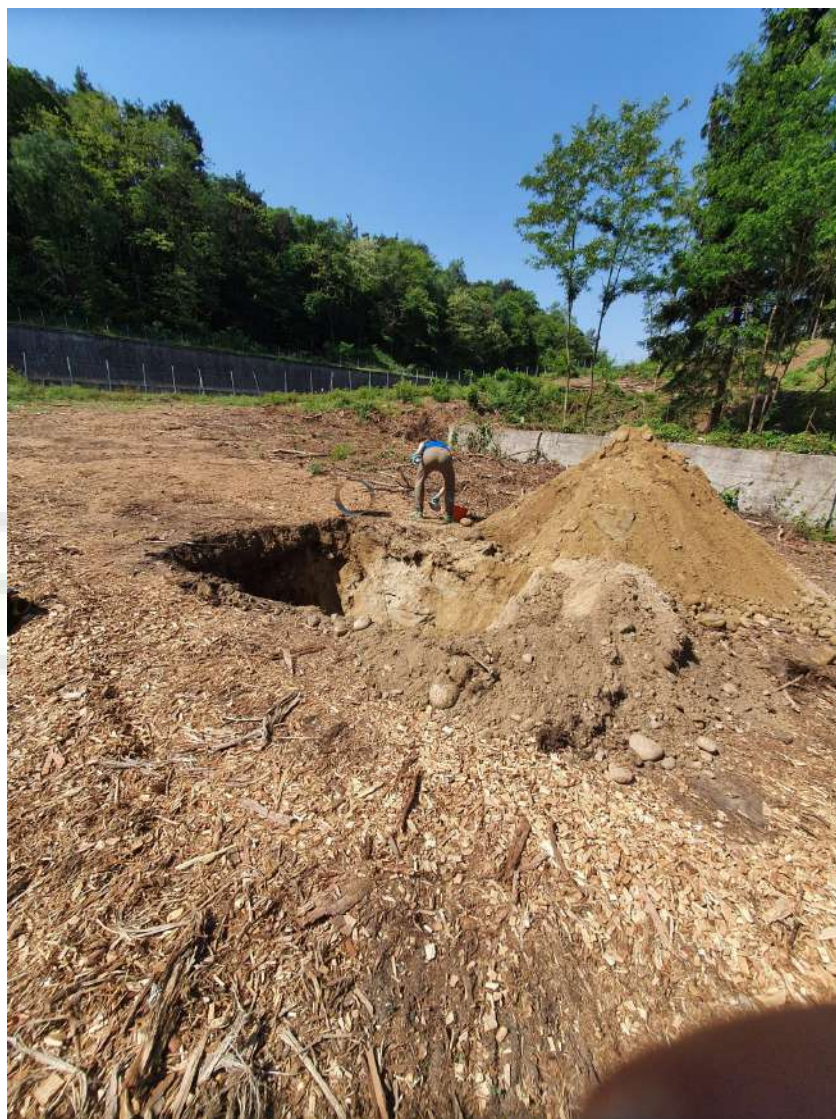
Fig.1 – Scavo Trincea
